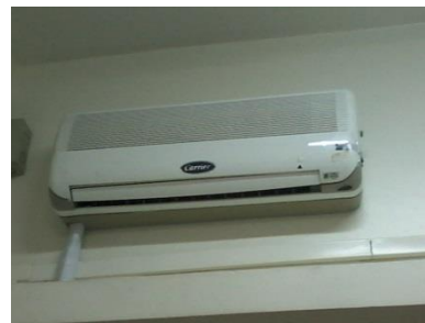
FIG 08 – Aparelho de ar-condicionado para ser removido
