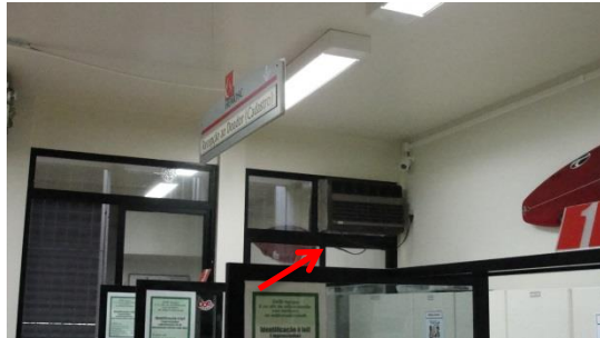
FIG. 01 - Remoção de equipamento 1 (Sinalizado com seta) – Setor de Coleta
