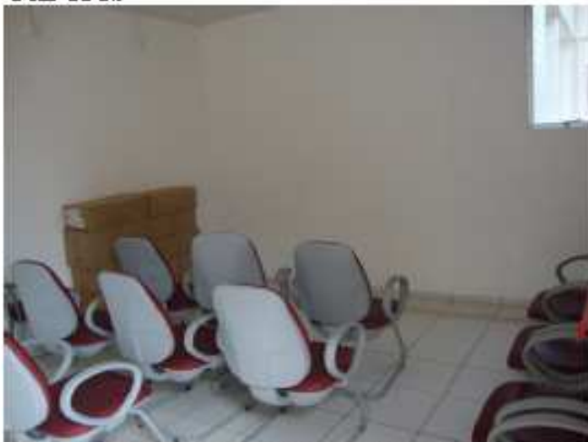
Figura 07 – Imagem da área atual usada como sala de reuniões da equipe e após reforma será transformada no Consultório 02 e Sala 02.
