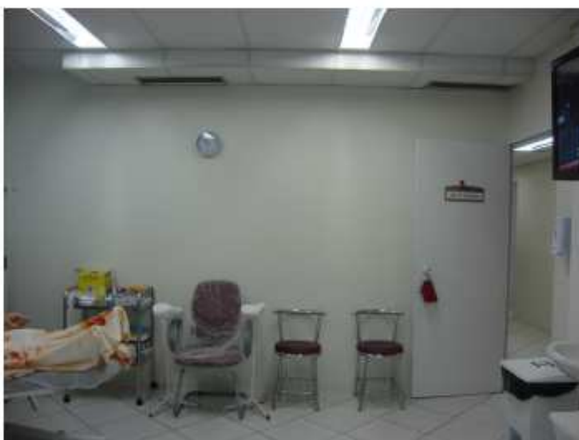
Figura 06 – Imagem da entrada da Sala de Transfusão a ser reformada
