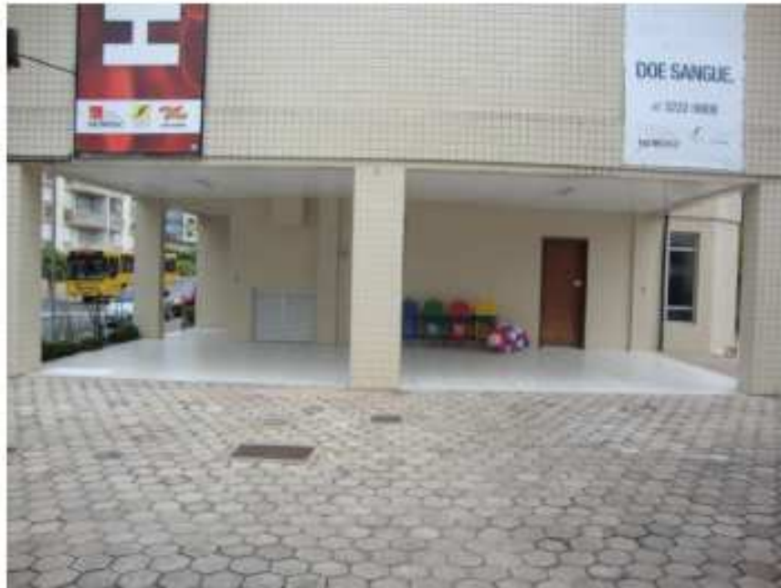
Figura 01 – Imagem lateral da área a ser fechada para ocupação dos vestiários de funcionários e copa.
