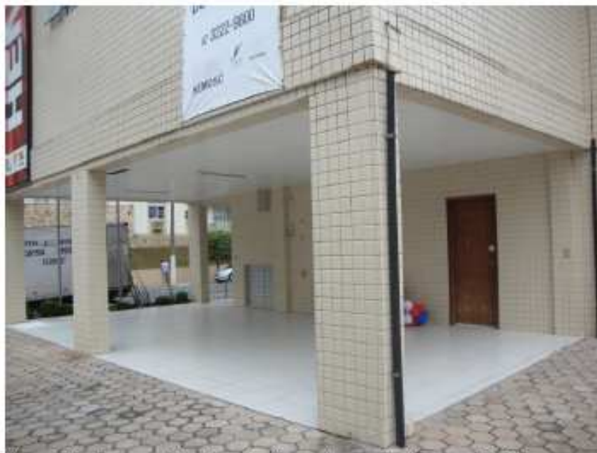
Figura 02 – Imagem da quina do pilar existente da área a ser fechada.
