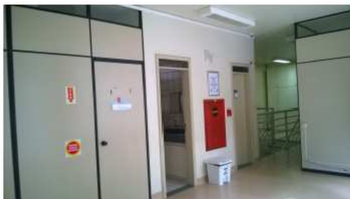
Figura 7 - Banheiros e acesso ao corredor
